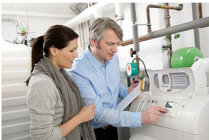
Besitzer von über 20 Jahre alten Ölheizungen sollten unbedingt noch dieses Jahr den Kauf einer modernen Ölheizung erwägen. Energieeffiziente Brennwerttechnik, moderne Sicherheitstanks, lukrative Förderung sowie eine relativ krisensichere Brennstoffversorgung sind starke Überzeugungsargumente. Foto: IWO
