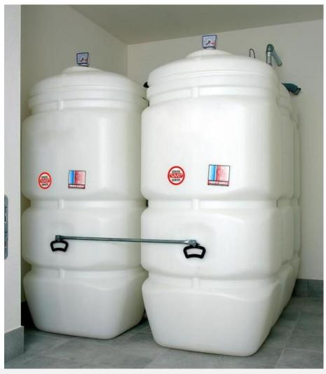
Moderne, doppelwandige Kunststoff-Tanks sind absolut alterungs- und korrosionsbeständig. Damit sind private Öltankbesitzer immer auf der "sicheren Seite". Zudem braucht man aufgrund der höheren Brennstoffqualität weniger Vorratsmenge, wodurch im Heizungskeller wiederum zusätzliche Stellfläche gewonnen wird. Weitere Hintergrundinformationen zu diesem Thema unter www.behaelterverband.de.
